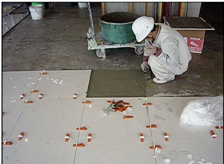
① 接着剤を床面に塗布する
