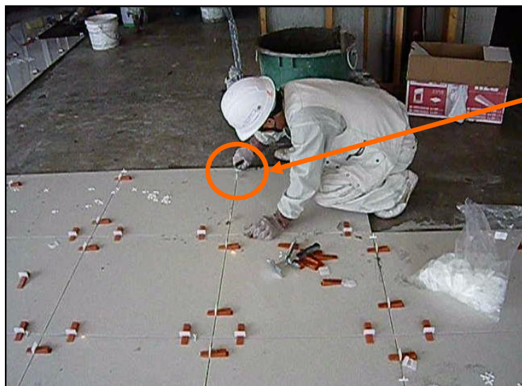
⑤ 目地ピッチで3mmの目地幅を確保する
