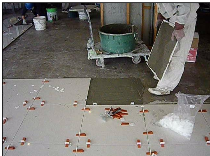
③ タイル裏面に接着剤を塗布する
