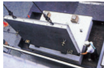
〔躯体へのファスナーによるPC板取り付け図〕
