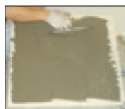
石材裏面しごき塗り (塗厚 1mm)
