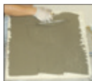
石材裏面しごき塗り (塗厚 1mm)
