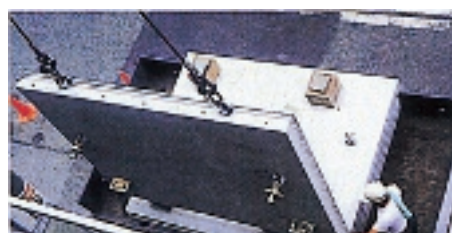
〔躯体へのファスナーによるPC板取り付け図〕
